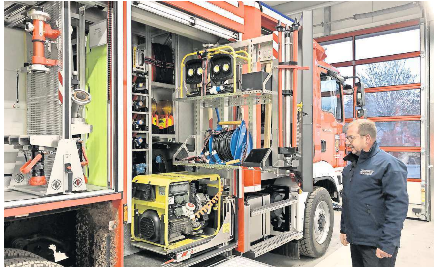
Das neue Fahrzeug der Ortsfeuerwehr Hilkerode, ein LF10, steht inzwischen im neu gebauten Feuerwehrhaus. Ortsbrandmeister Hans-Jürgen Ahlborn ist froh, dass die Zeiten im maroden Altbau vorbei sind. FOTO: EICHNER-RAMM
